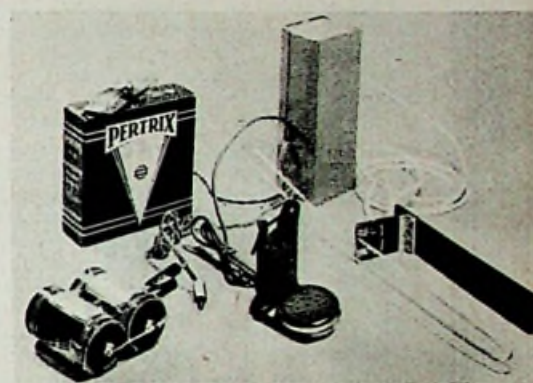
Zusammenstellung aller vom Redner zu tragenden Teile der „drahtlosen“ Redner-Anlage
